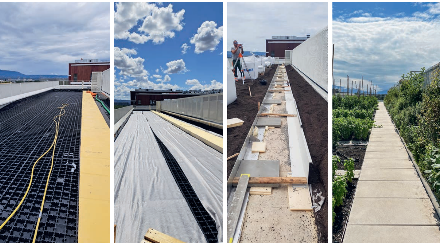
Quelques étapes dans l'ordre de leur réalisation, des plaques de rétention jusqu'aux planches en cultures. photos: Bocard SA
