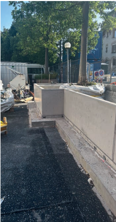
Fig. 7, 8 et 9: Muret en béton armé type 4 sur sa semelle inversée coulée sur la protection d'étanchéité de la dalle de sous-sol. On devine la présence des réservations pour le passage de l'eau sous la fondation. Les mottes des arbres, encore protégées par le matelas pédologique, sont prêtes à être remblayées avec de la terre végétale enrichie de compost. Centre: Les micocouliers retrouvent un environnement racinaire plus favorable grâce à la présence de murets de soutènement, en gneiss du côté rue pour conserver la typologie des bordures existantes, en béton côté nouveau pavillon de l'EMS. Droite: Où l'on peut admirer la qualité de finition du béton d'un muret qui remplit parfaitement sa fonction pour accueillir un «brim» de végétation et permettre de créer un lieu en contre-bas, protégé de la rue trop proche. photos: Jacquet SA, Eric Amos (centre et droite)
