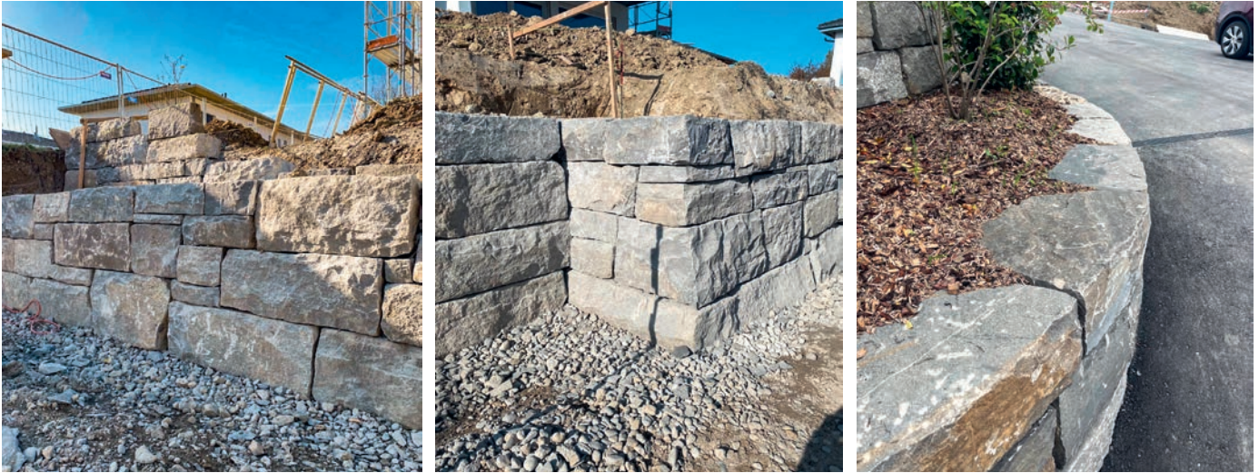
Cas de figure 1: Détails de construction selon les principes des murs de pierre sèche: fondation flottante, assises horizontales, joints ajustés, fruit du parement, façon d'angles et courbes soigneusement appareillés – une réalisation exemplaire. photos: E. Amos/1001 Jardins
