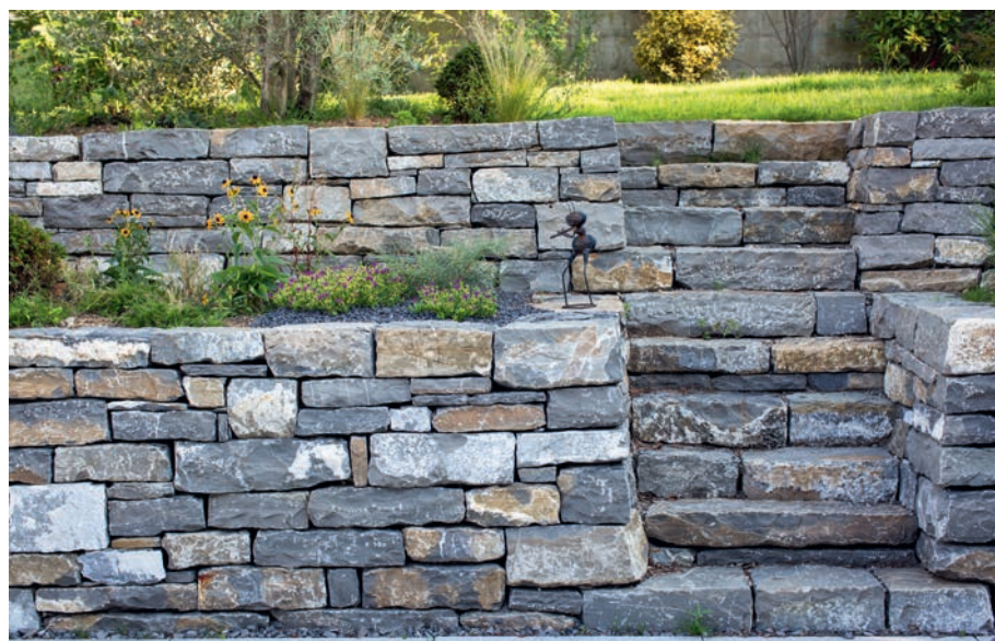
Cas de figure 2: Ouvrage de soutènement pour gagner de la surface de plantation et d'usages par la construction d'un ensemble murs/escaliers favorable à la biodiversité. photo: 1001 Jardins
