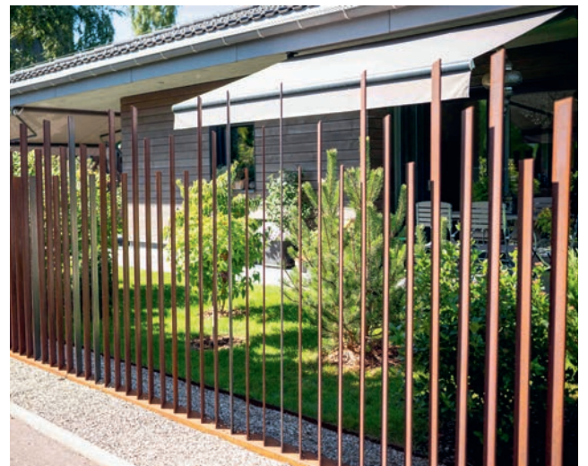
Fig. 10, 11: Lames brise-vue. Détail de scellement (croquis). Le principe du brise-vue est de filtrer le regard, maintenir une transparence tout en occultant les vues directes. S'utilise généralement par séquences ciblées sur des angles de vues stratégiques. photo: Schaller, croquis: E. Amos & B. Goyard
