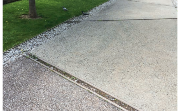
À g.: Les «revers d'eau*» pour limiter le ravinement, une contre-pente et un fossé pour capter l'eau de ruissellement des chemins de montagne. À d.: Version contemporaine des «revers d'eau», pour la récolte des eaux météoriques dans un aménagement urbain. photos: Eric Amos
