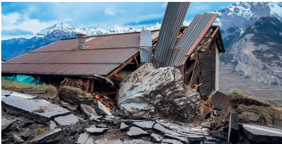
Le 9 mars 2024, sur les hauteurs de Nendaz, un bloc de 50 m 3 dévale la pente dans la forêt et arrête sa course dans une écurie occupée par 40 vaches, heureusement sans faire de victimes. photo: Le Nouvelliste
