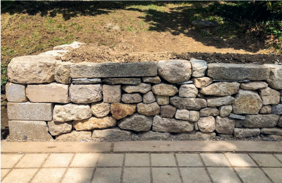
Valorisation de matériaux issus de la démolition insérés dans un mur de soutènement (à g.). Comme on le voit, la pierre sèche favorise la biodiversité sous toutes ses formes. Ici une couleuvre à collier dans la plaine de l'Allondon/Genève. photos: Eric Amos
