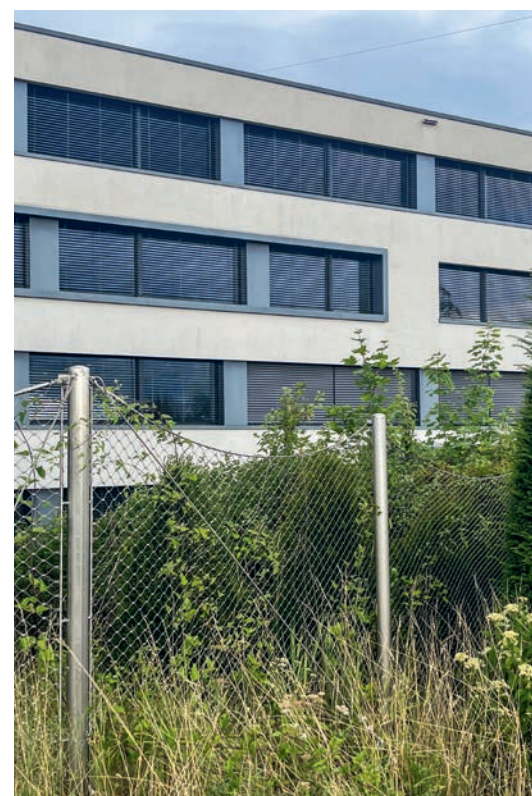
Fig 5: Les panneaux de 2 x 4 m de filet inox tendu sur câble et «festonnés» entre poteaux sont en retrait et insérés dans les végétaux, ce qui confère au tout une apparence moins rigide.
