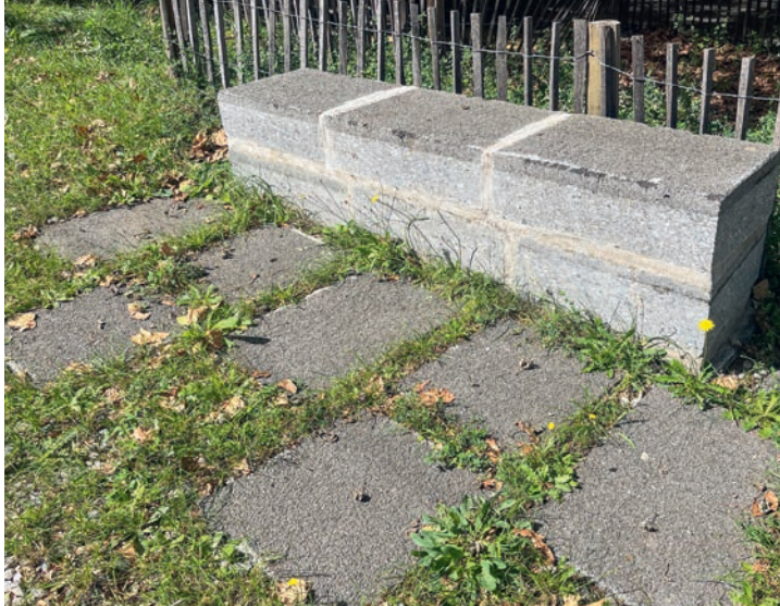
Fig. 1: Concilier usages et nature: Une forme de nature a pris place dans une surface minérale «descellée» (ici à Genève, Rive), perméable, qui se verra agrémentée par la canopée des platanes existants accompagnés d'une végétation rudérale dans un mélange terre/pierres. Un compromis encore expérimental mais prometteur pour concilier usages et nature en ville. photo: E. Amos
