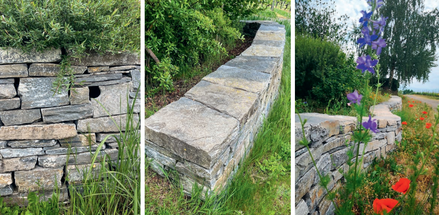
Cas de figure 3: Détails de réalisation: nichoir à huppe intégré dans le corps de mur (à g.), une tête de mur très soignée, couronnement d'une belle régularité qui invite à s'asseoir (centre) et enfin, la forme sculpturale du mur qui s'associe harmonieusement au paysage et à la végétation. photos: Eric Amos (g. et c.)/1001 Jardins
