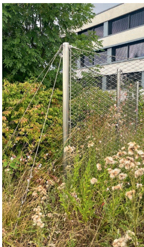
Fig. 4: Les changements de direction de la clôture tendue sur câbles inox nécessitent le haubannage des poteaux d'angle, une solution plus «légère» que des jambes de forces.
