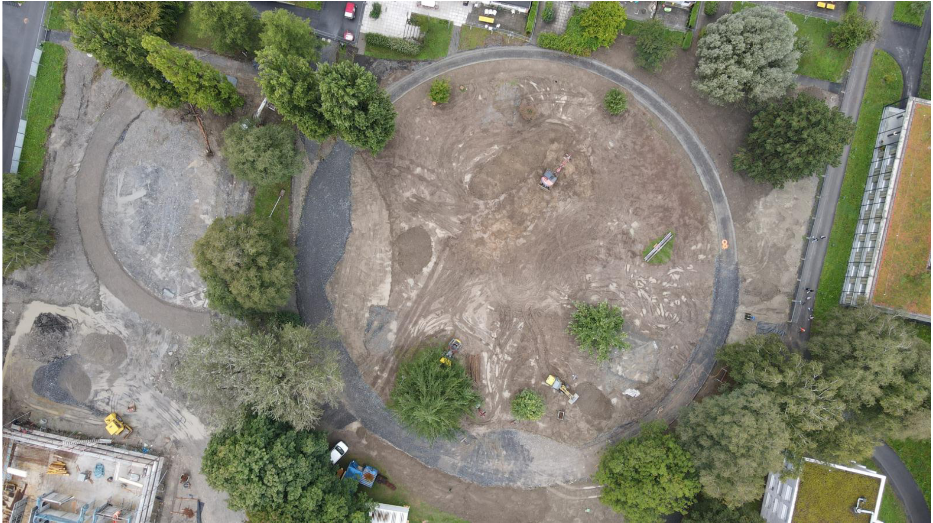
PHOTO DU CHANTIER, KEN ARCHITEKTEN, SEPTEMBRE 25
