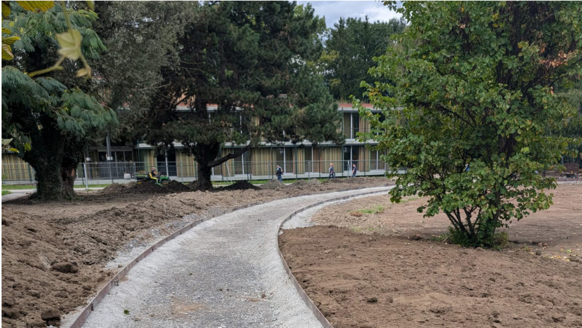
PHOTO DU CHANTIER, KEN ARCHITEKTEN, SEPTEMBRE 25
