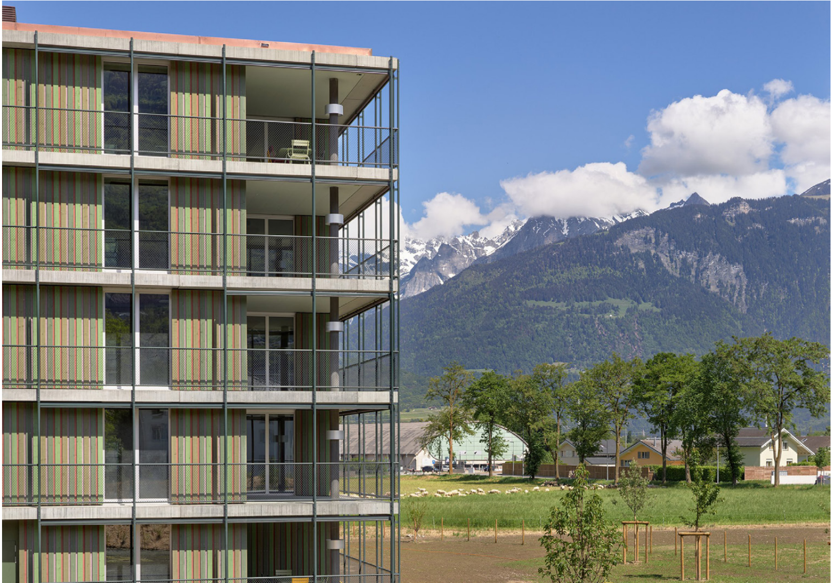
PHOTO BÂT. 1, KEN ARCHITEKTEN
