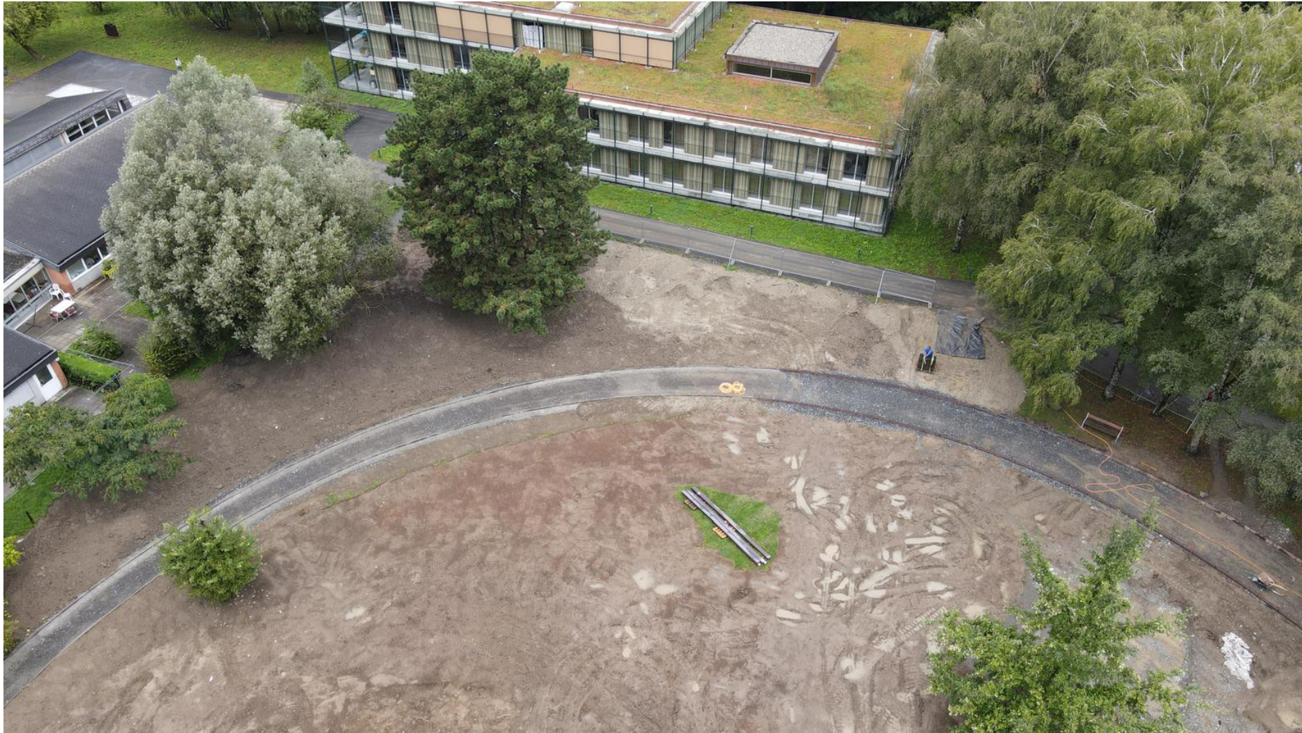
PHOTO DU CHANTIER, KEN ARCHITEKTEN, SEPTEMBRE 25
