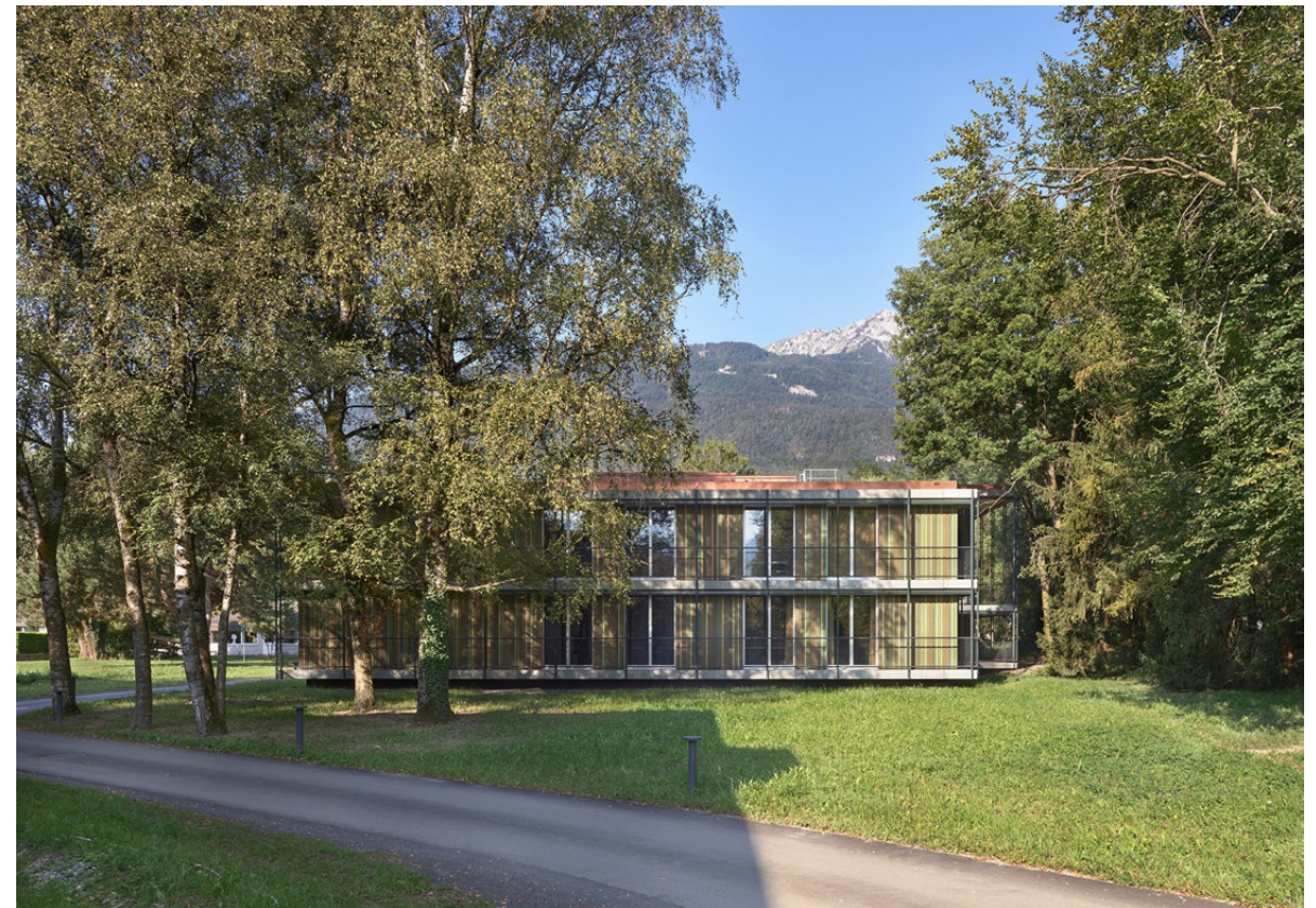
PHOTO BÂT. 2, KEN ARCHITEKTEN
