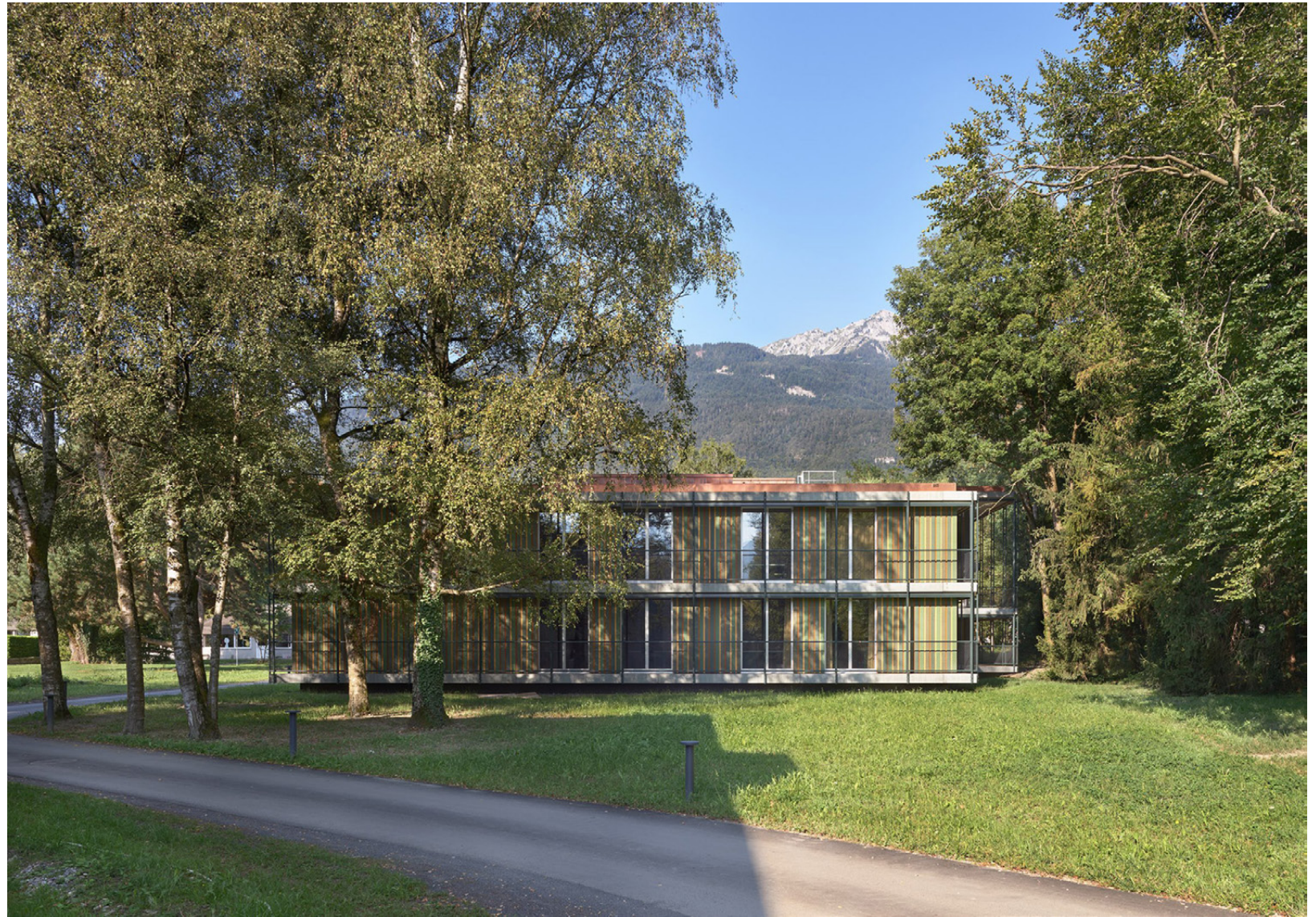
PHOTO BÂT. 2, KEN ARCHITEKTEN
