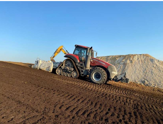
Epône (78) Fabrication du substrat fertile (phase du mélange)
