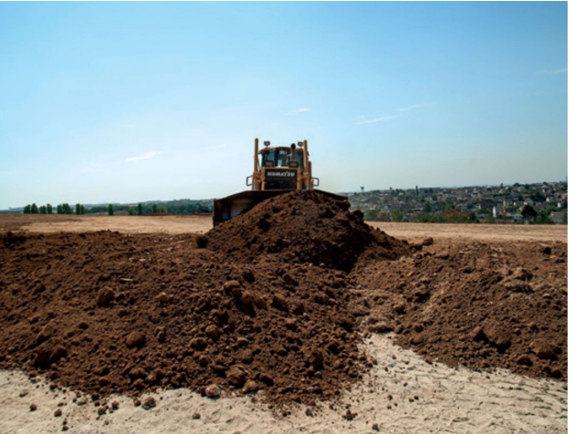
Louvres (95) Remise en place des terres végétales sur les terres inertes
