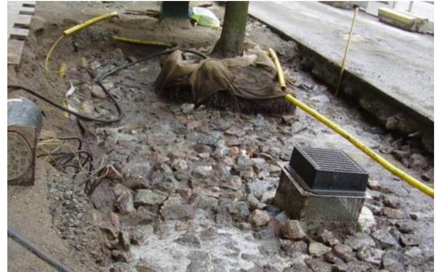
Couche d'infiltration de l'eau de pluie sur le sol structuré
