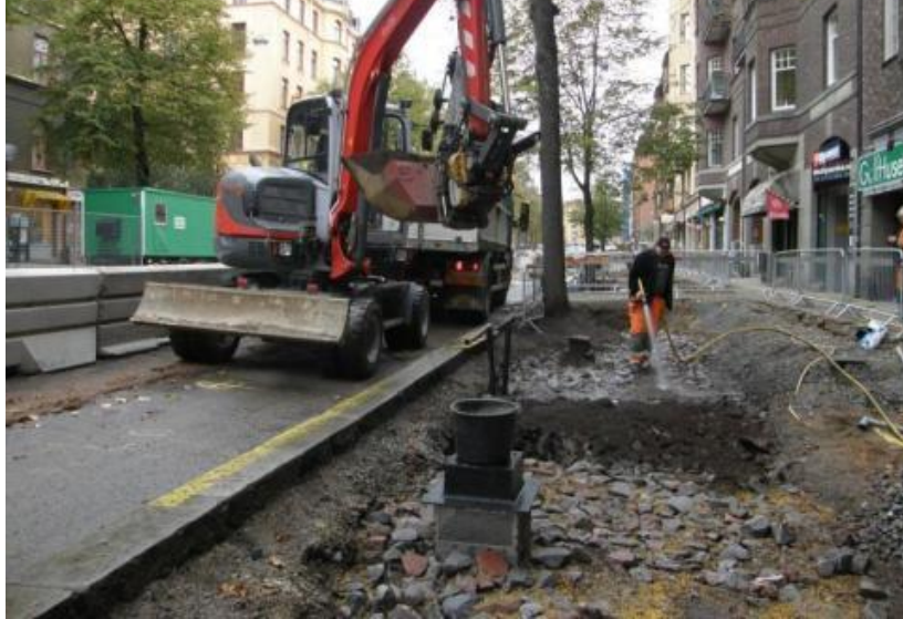
Faire pénétrer le mélange dans la structure
