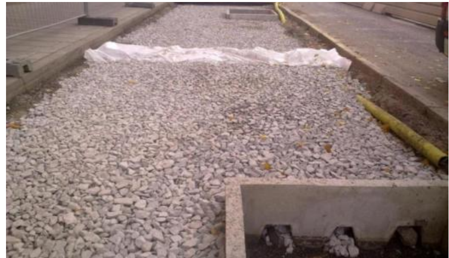
Couche d'infiltration de l'eau de pluie sur le sol structuré
