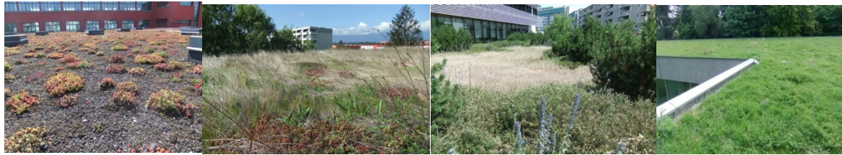
Figure 1. Toitures végétalisées n° 11, 42, 62 et 61.
